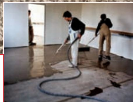
Завод MAGNA SREYR GROUP - Грац - Вена Австрия Подготовка основания: NIVORAPID, ULTRAPLAN, PRIMER G. Укладка натурального линолеума: AQUACOL T
